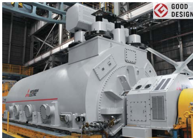
900MVA級水素間接冷却発電機の実機検証状況
