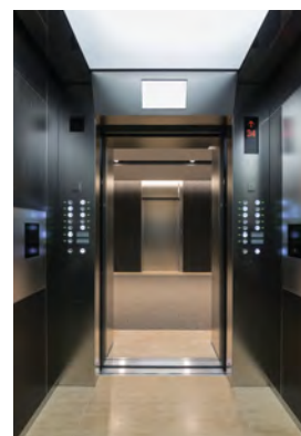
図2. ダブルデッキ エレベーターの かご室内
