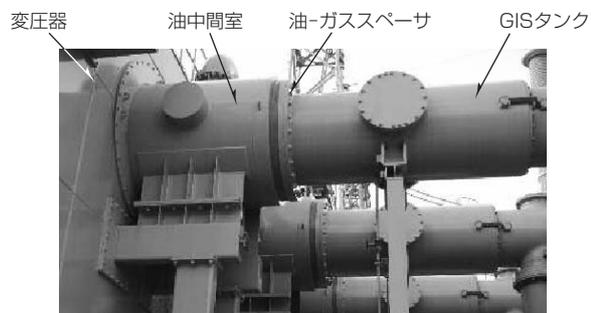
図3. 油-ガススペーサの適用例<sup>(3)</sup>
