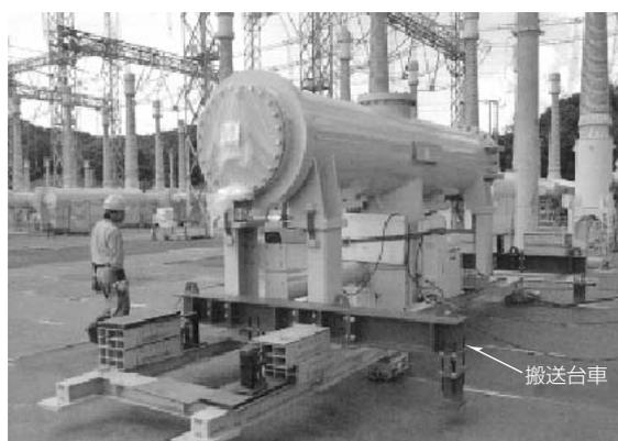
図6. 重機作業レス工法<sup>(5)</sup>
