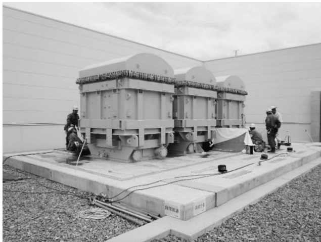
図10. 基礎据付状態
