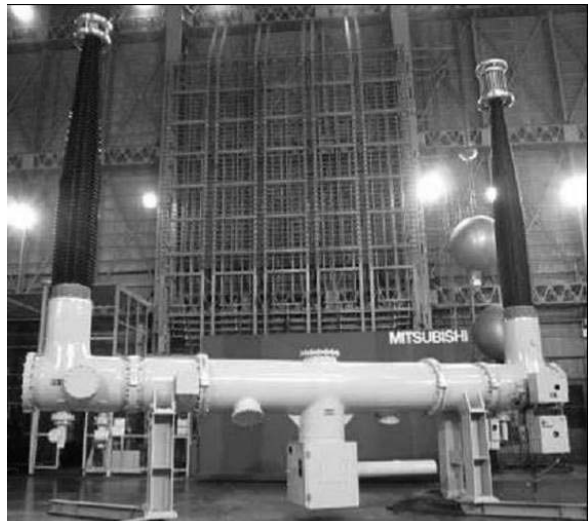
図8. 550kV 2点切ばね操作GCB
