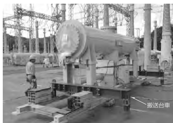
図 6. 重機作業レス工法 (5)
