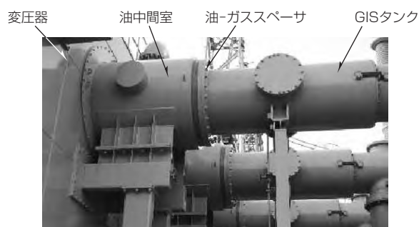
図3. 油-ガススペーサの適用例 (3)
