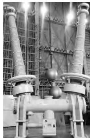
(a) 550 kVばね操作GCB
