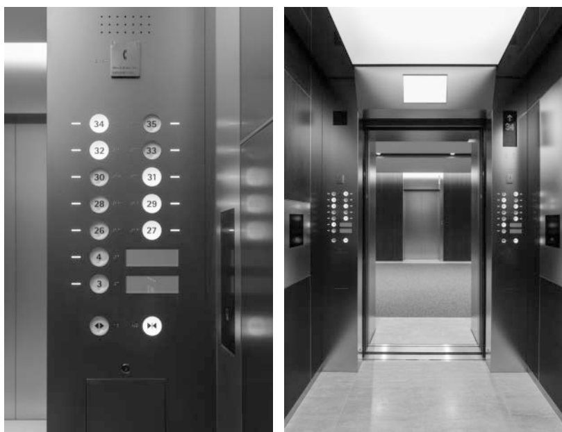
(a) 行先ボタンと停止可能階を示す表示灯 (b) エレベーターのかご室内 図2. 虎ノ門ヒルズのオフィス用エレベーター
