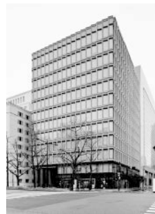
淀屋橋東京海上日動ビルディング
