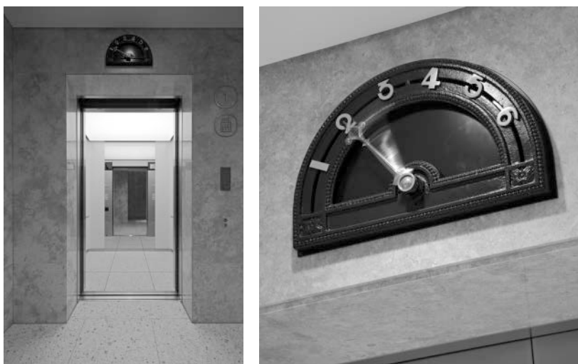
(a) 1階エレベーター乗場 (b) 乗場位置表示器 図1. 日本橋ダイヤビルディングの低層用エレベーター
