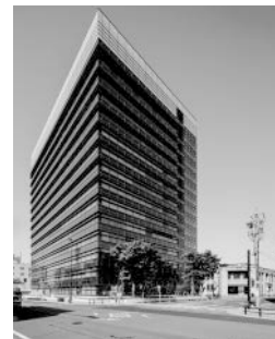
一宮市役所本庁舎
