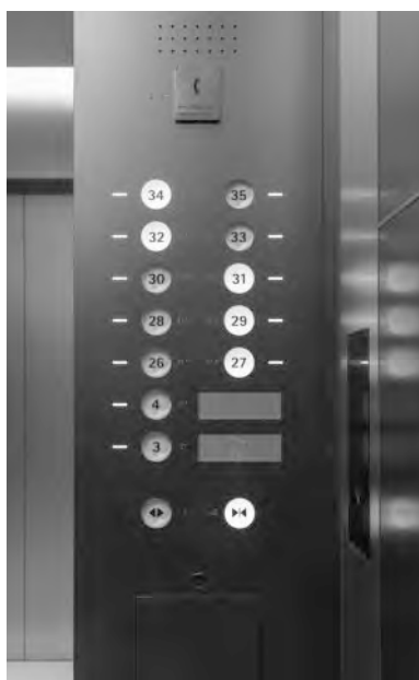
(a) 行先ボタンと停止可能階を示す表示灯
