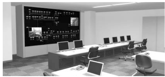
図1. 電力管理システムの指令所
