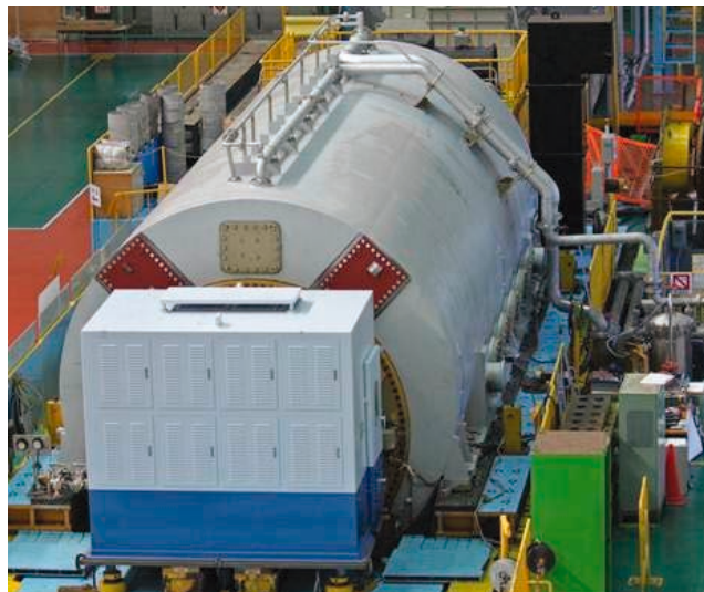
793MVAラジアルベント式水冷却タービン発電機
