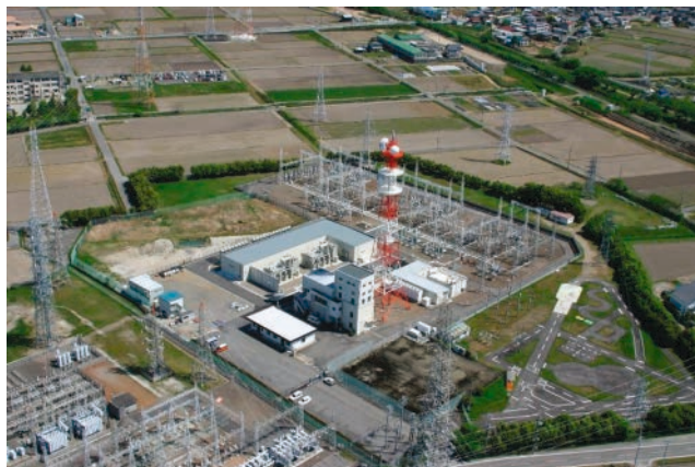
関西電力(株)犬山開閉所納めのSTATCOM
