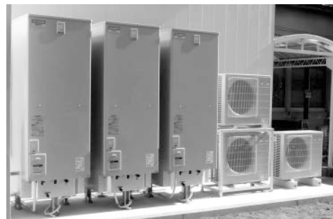
図3. 小型業務用エコキュート(食堂厨房設置)
