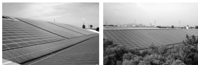
図2. 設置した太陽光パネル
