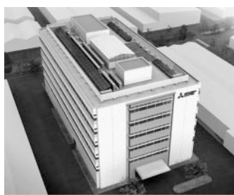
図 8. 太陽光発電システム
