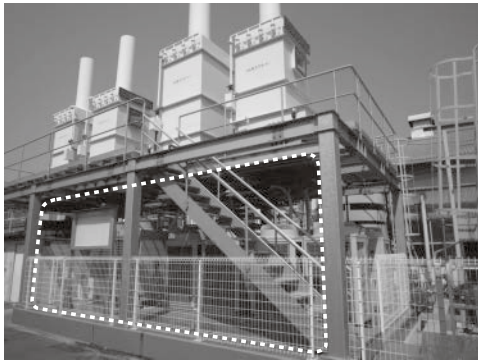
図5. ヒートポンプの設置場所
