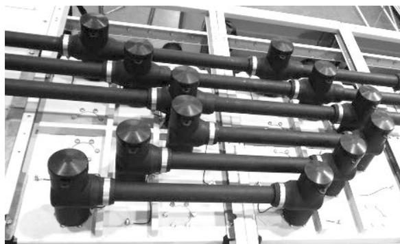
図5. 固体絶縁母線の適用事例
