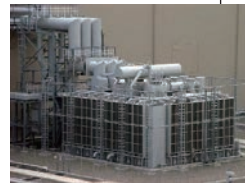
図5. 1,510MVA変圧器
