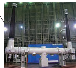
図3. 550kV 2点切ばね操作GCB
