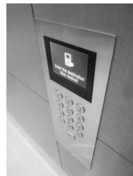
図7. エレベーター乗場操作盤
