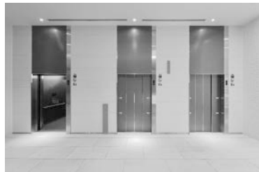
図17. 1階エレベーター乗り場
