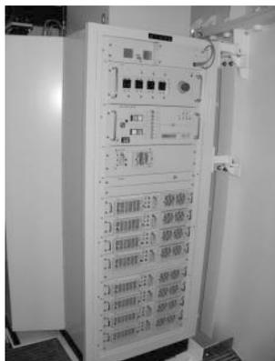
図6. S帯1kW電力増幅装置の外観(画像提供：JAXA)
