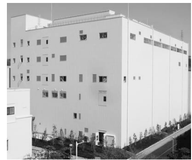
図9. 新人工衛星生産棟の外観
