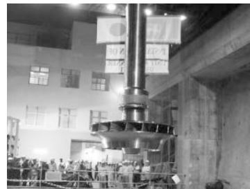
図8. 2号機ランナ吊(つ)り込み
