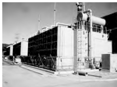
連系用・変換用多重変圧器 (特別三相形、防音壁一体構造)
