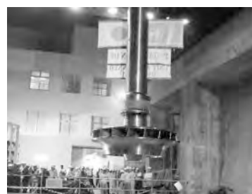
図8. 2号機ランナ吊(つ)り込み
