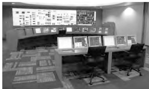
図2. 中央計装システムの運転検証設備
