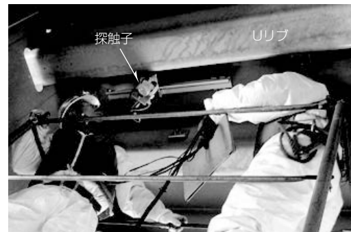
図6. 実橋鋼床版での適用状況
