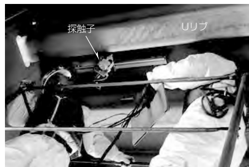
図6. 実橋鋼床版での適用状況
