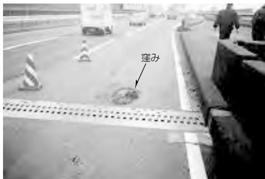
図1. 路面に発生した窪み
