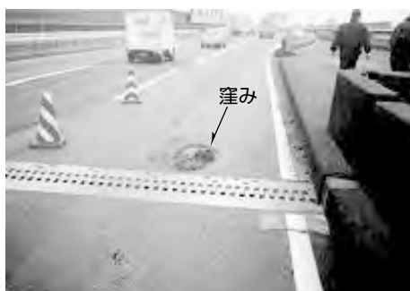
路面に発生した窪み
