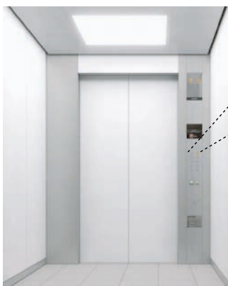
LEDフラット天井
