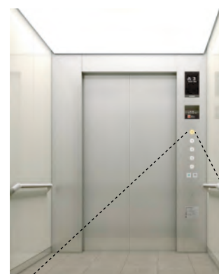
LEDガラスクロス天井
