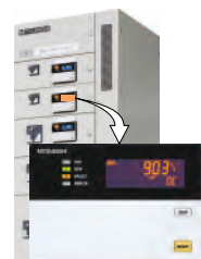
図4. 段積状態でのトリップ表示(EMC-B)
