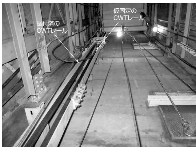
図7. レール抱き合わせ状態(昇降路内)
