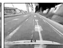
(h) 路面標示
