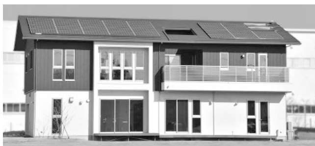
図1. 大船スマートハウスの外観
