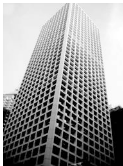
Gloucester Tower 香港/中国
