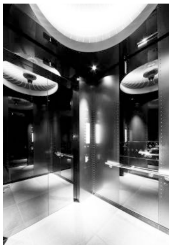
図6. シャトルエレベーターかご室
