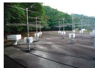
図3. 国内での仮組立ての様子
