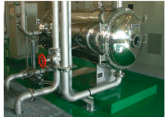
東村山浄水場向けオゾン発生装置
