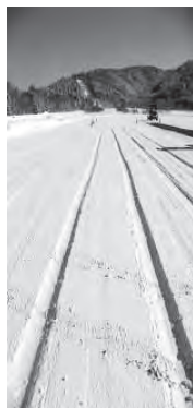
路面の荒れ(雪道のわだち路)
