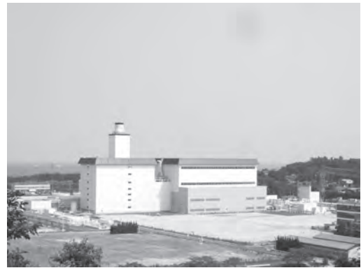
仙台火力発電所第 4号機全景
