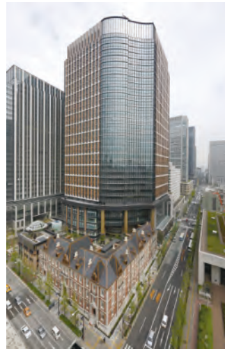
丸の内パークビルディング・三菱一号館 (新建築社撮影)
