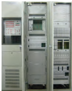
炉内核計装装置
