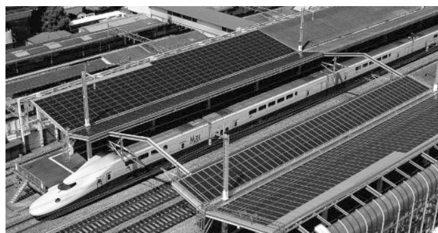
図3. 太陽光発電システムの設置事例
