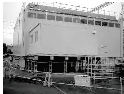
図7. 500kV級変圧器の現地組立てハウスの外観
