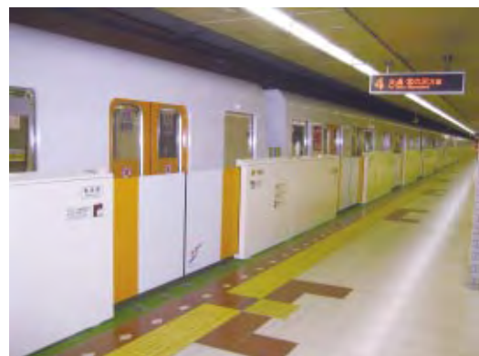
札幌市営地下鉄の可動式ホーム柵(南郷7丁目駅)
