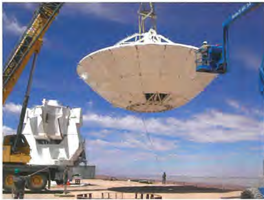
図1. 主鏡部を架台部へ吊(つ)り込む様子
