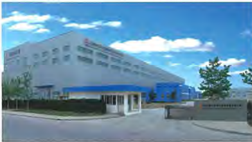
新しく稼働した開閉機器工場
