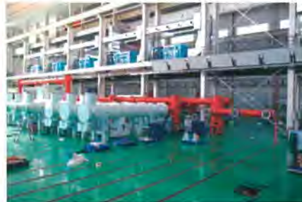
総組立工場内浄化エリア
