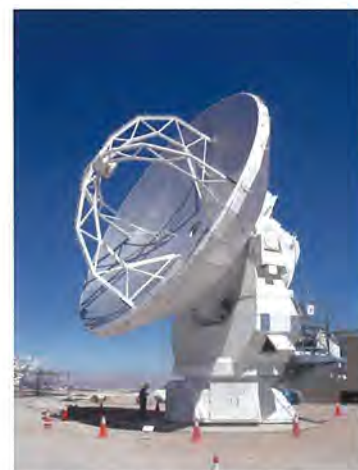
図3. OSFで組立・調整中のアンテナ
