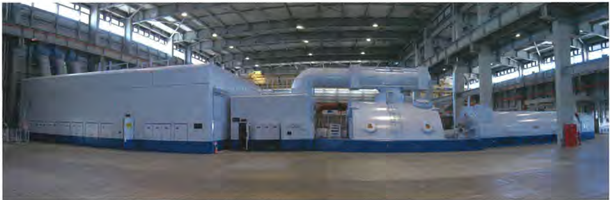
東京電力(株)川崎火力発電所タービン・発電機
