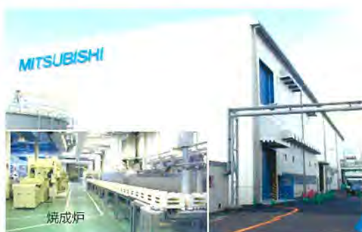
新しく稼働した避雷器素子工場
