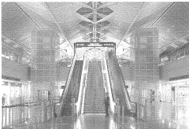
図4. 旅客ターミナルビルのエレベーター、エスカレーター
