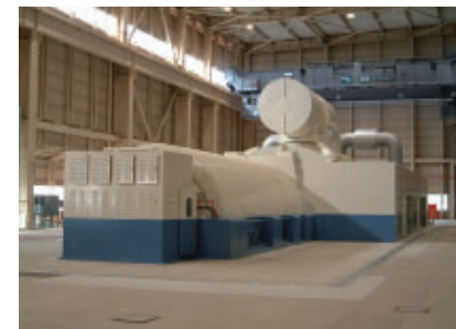
広野火力発電所5号機タービン建屋
