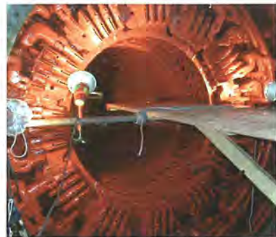
1号発電機固定子巻線更新
