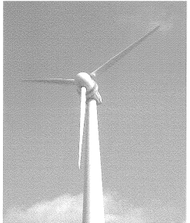
三菱可変速風力発電設備の外観
