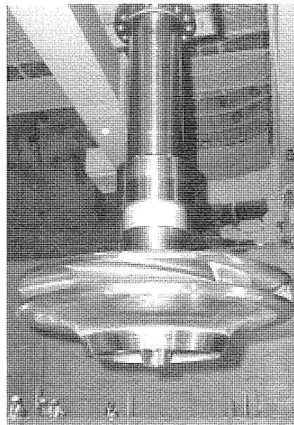
図3. ランナ吊り込み状況
