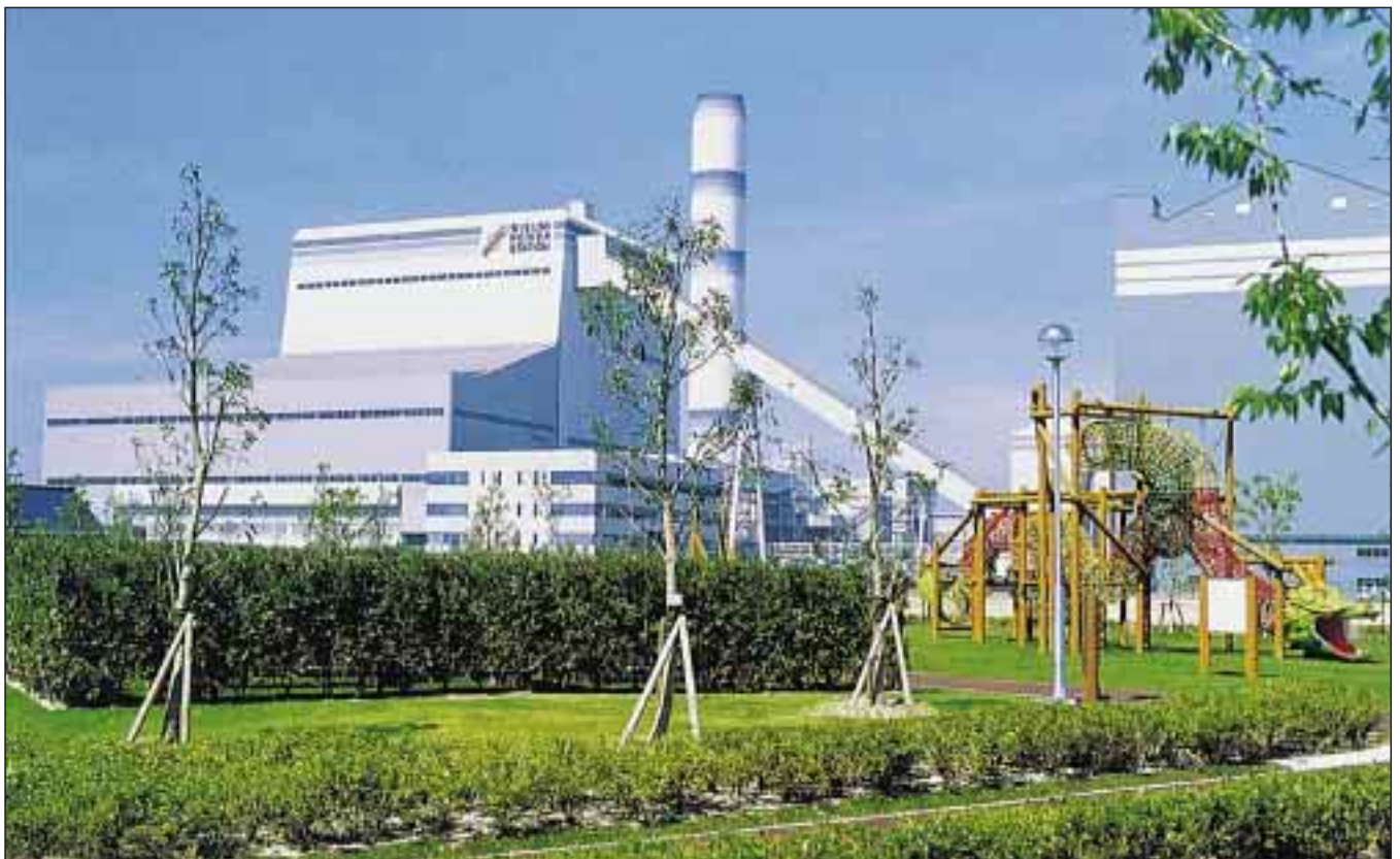
中国電力(株)三隅発電所第1号機
