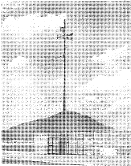
図7. 同報系屋外拡声受信装置
