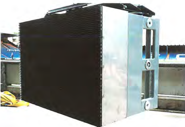
専用吊具によるモジュール吊上げ状態
