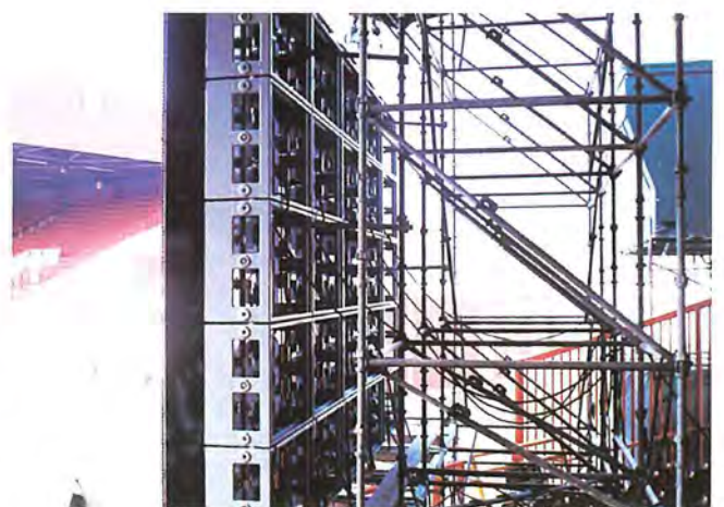
スクリーン組立て完成状態(5段×5列)
