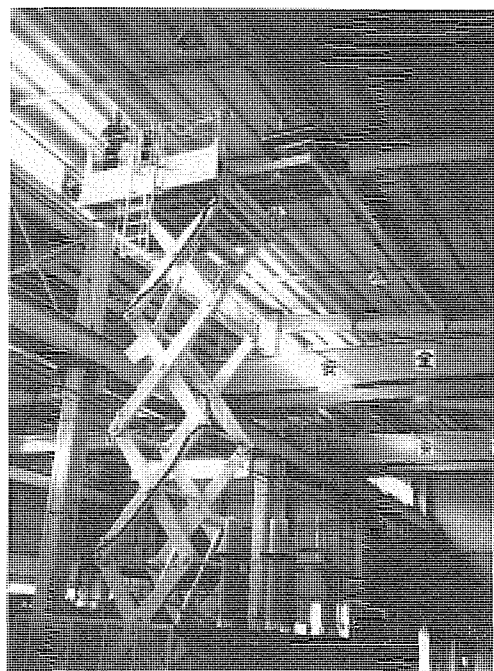
図17. モジュール保守用リフト
