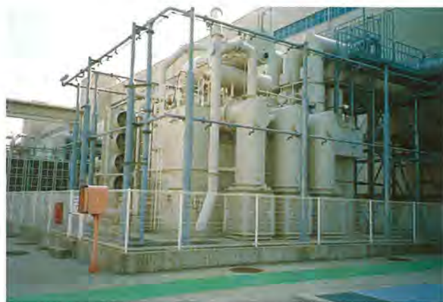
220kV 410/271-139MVA異容量スプリット巻線変圧器
